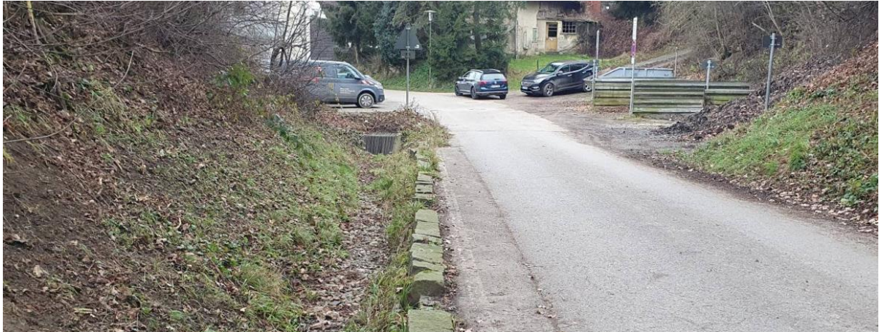
Foto offener Graben im Hohlweg mit derzeitigem Einlauf in den Mischwasserkanal
